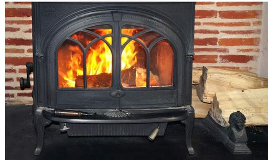
respecter des limites de dégagement des matières combustibles. Il est très important que les divans, rideaux et autres matières soit à 4 pouces de dégagement au-dessus et devant afin de limiter le risque d'incendie relié au système de chauffage.
